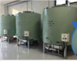
樹脂ライニングタンク型 クーリングタンク (NYK 西日本製)
